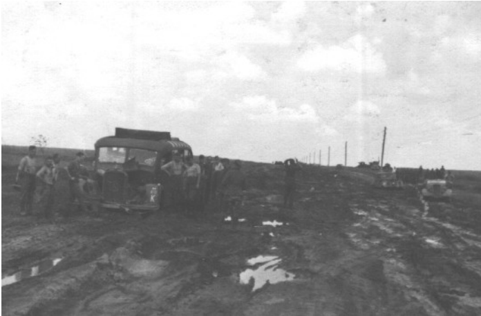
Strassenzustand bei Nässe
