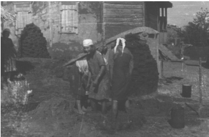
Auf dem Lande Bausteine Herstellung Lehm und .... mischen, trocknen
